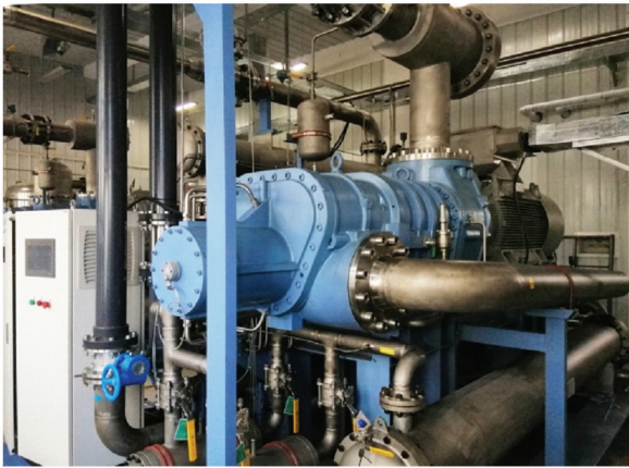
图2 2.5 kW/4.5 K氦制冷机的氦气喷油式螺杆压缩机主机图
